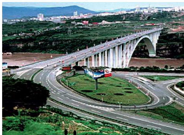
Fig. 26. Wanxian bridge, China, 1997 (420 m)
