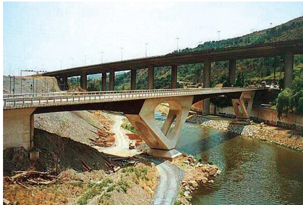
Fig. 18. Julio M. Calzon, “del Diabolo” bridge over the Llobregat river, Martorell (Barcelona), 1975 (100 m)
